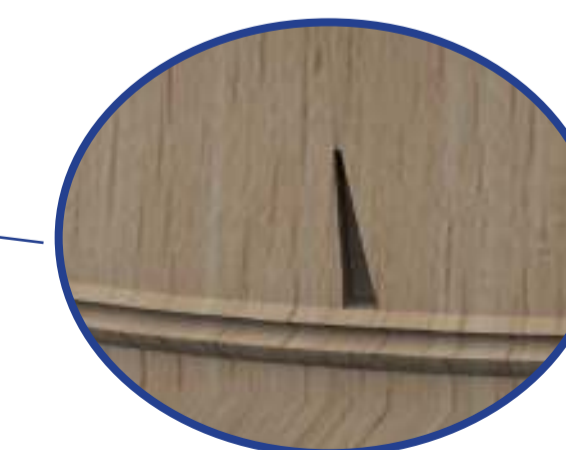
Dettaglio maniglia esterna semi-nascosta
